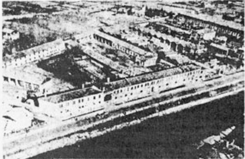
Una veduta "storica" della Krull in via Forte Marghera.
